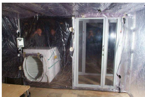
Wnętrze izolatorium widok na śluzę i filtr
