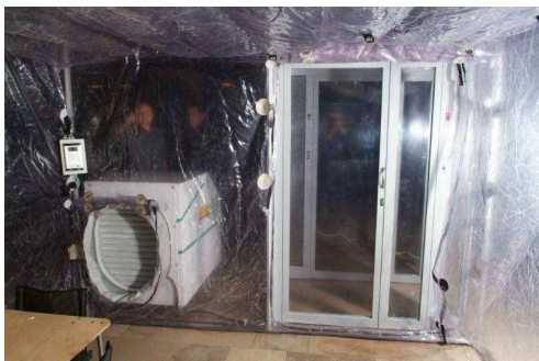
Innenraum des Isolierzeltes – Ansicht der Schleuse und des Filters
