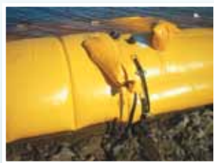
szczelność połączenia pomiędzy zaporami
